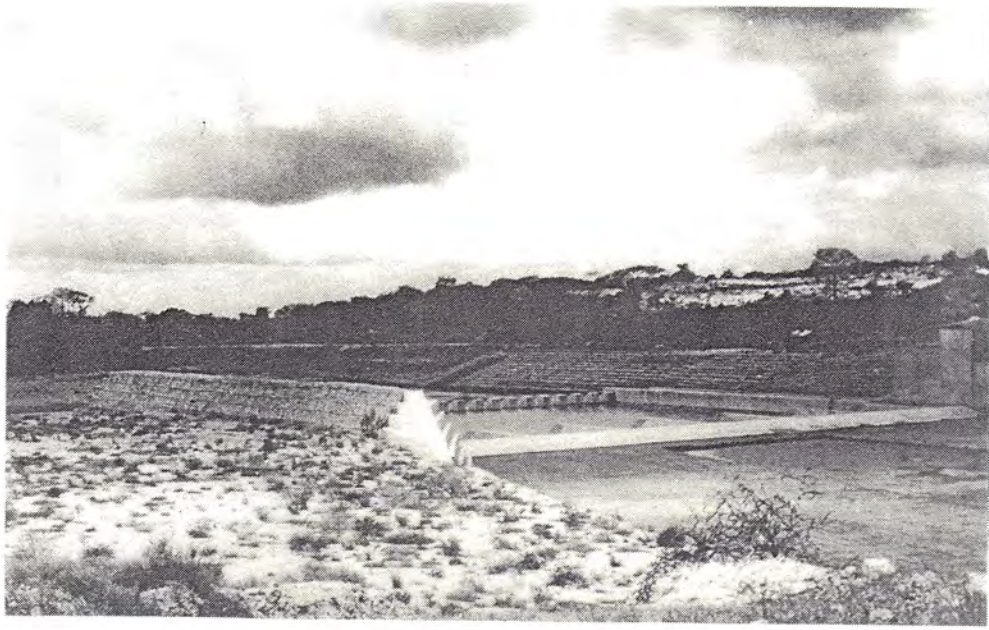
P.3. Baricho Weir
